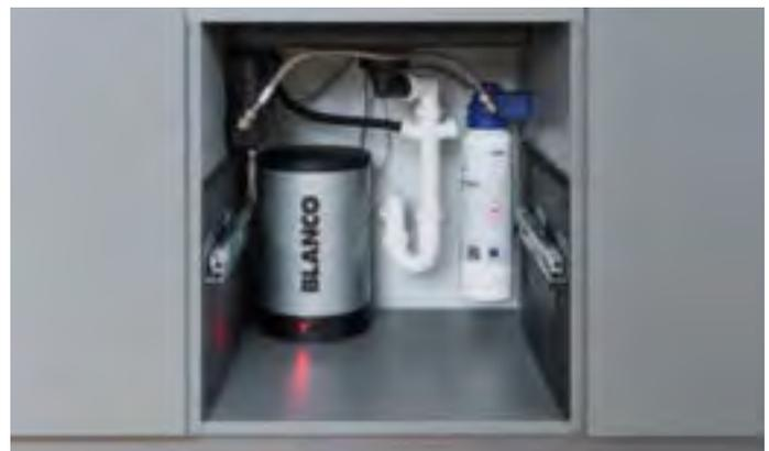
Links: 4-Liter-Heißwasserboiler aus widerstandsfähigem Titan. Rechts: Hochwertiger Mehrstufenfilter von BWT für weniger Kalk und mehr Geschmack.
